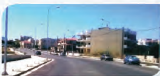
ΚΑΤΑΣΚΕΥΗ ΠΕΡΙΦΕΡΕΙΑΚΟΥ ΔΡΟΜΟΥ ΑΛΕΞΑΝΔΡΟΥΠΟΛΗΣ
