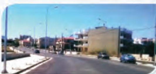
ΚΑΤΑΣΚΕΥΗ ΠΕΡΙΦΕΡΕΙΑΚΟΥ ΔΡΟΜΟΥ ΑΛΕΞΑΝΔΡΟΥΠΟΛΗΣ
